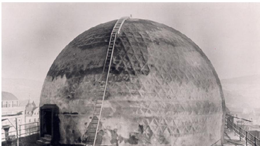
*Foto: Cobrindo a primeira cúpula com ferrocimento*
