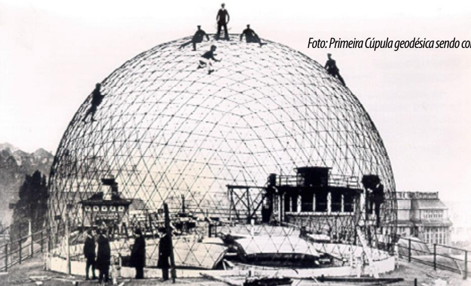
*Foto: Primeira Cúpula geodésica sendo construída..*
