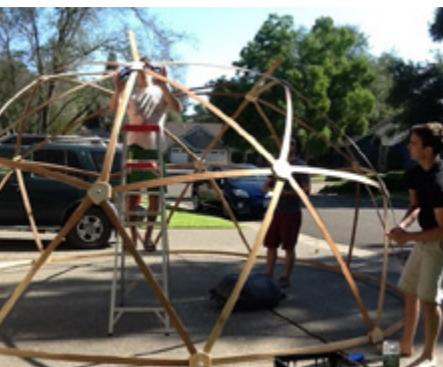
*Método de Conexão plana (sem angulação) e barras flexíveis (repare as barras fazem curvas)*
